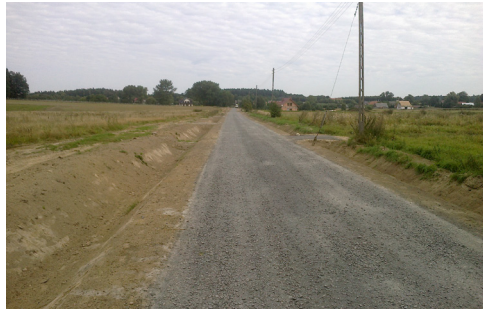
Droga w Kikorzu - 340 tys. zł - dofinansowanie FOGR 194 tys. zł
