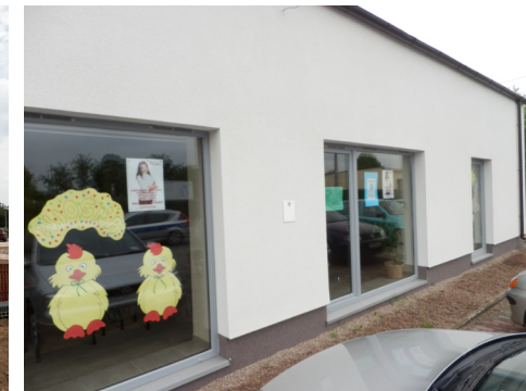
Przebudowa i remont świetlicy w Osinie – wartość inwestycji - 388 tys. zł - dofinansowanie PROW 230 tys. zł
