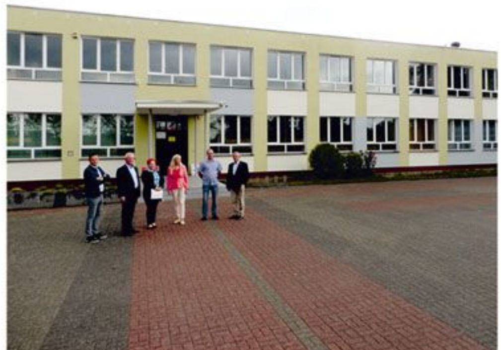
Malowanie elewacji Szkoły Podstawowej w Osinie Wartość zadania 189.917,29 zł
